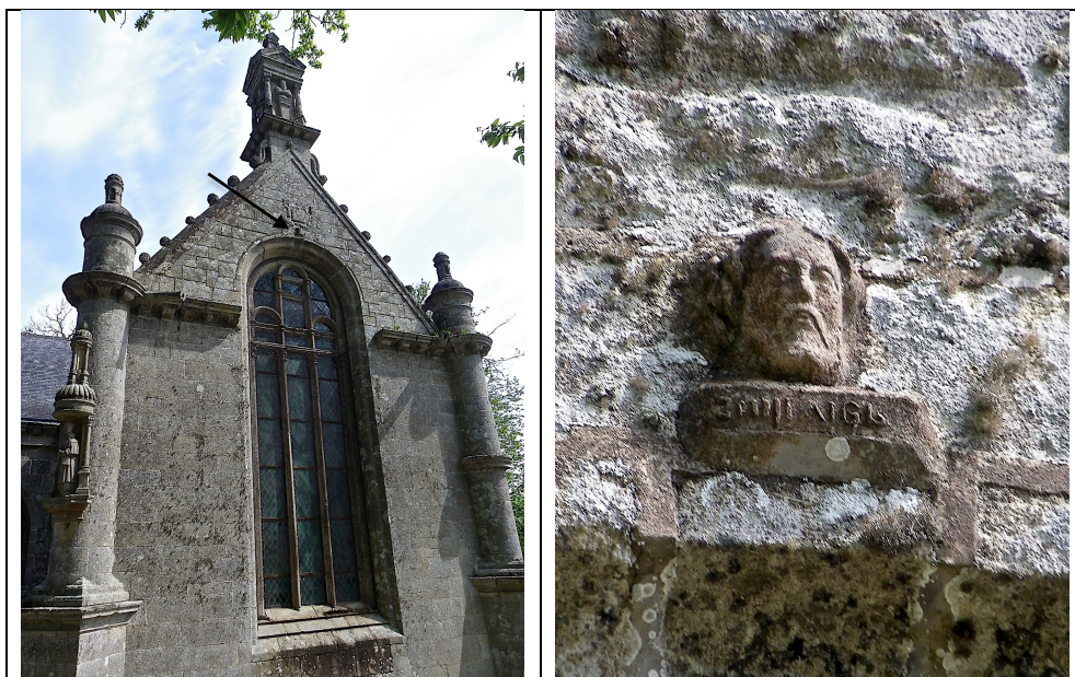
La façade sud de la chapelle St Yves de Kerfons. La flèche indique l'emplacement de la figure de droite
